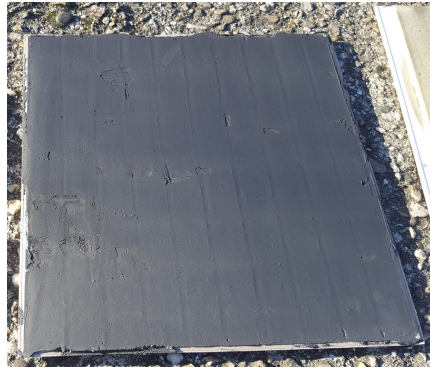
Figure 5 : Enduit sur la face inférieure du carrelage
